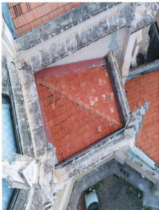
Cobertura da sacristia esquerda de telha francesa.
