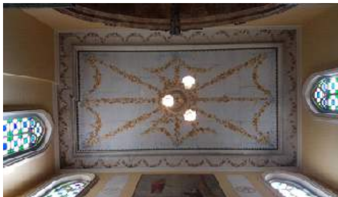
Foto 3 – Forro do Transepto – lado do Evangelho – Acervo IEPHA/MG.
