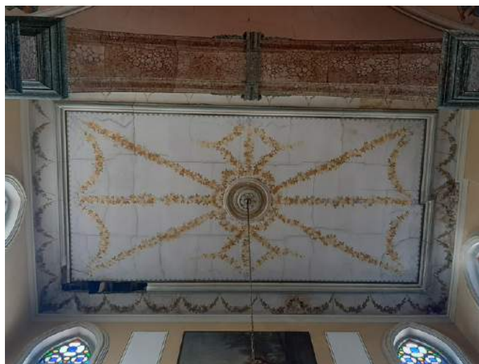
Foto 4 – Forro do Transepto – lado da Epístola – Acervo IEPHA/MG.
