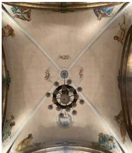
Foto 5 – Forro do Centro do Transepto – Acervo IEPHA/MG.
