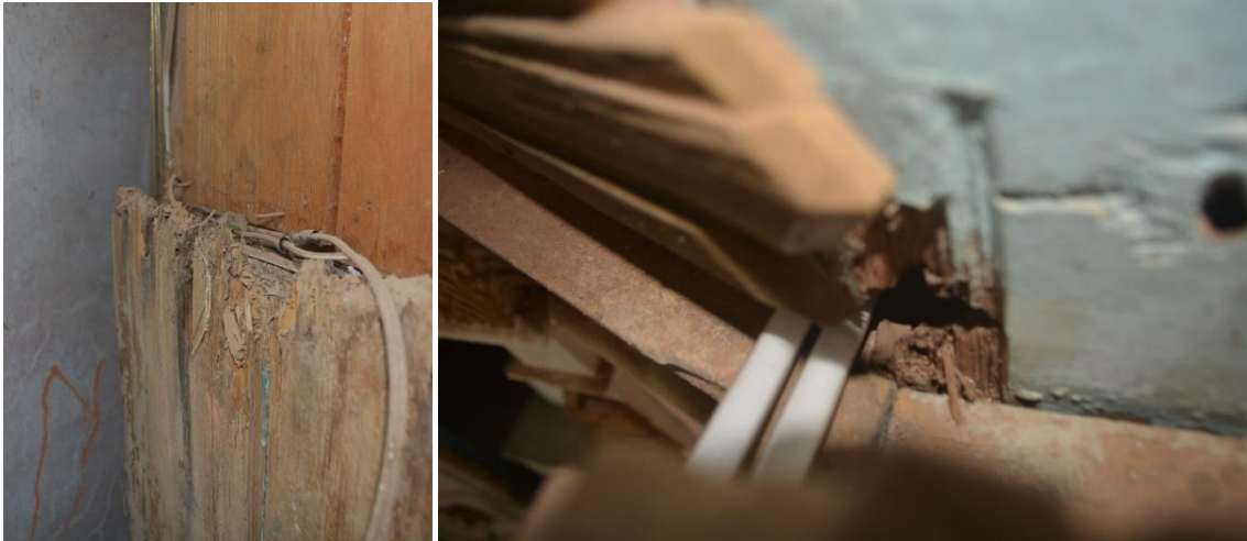
Figuras 61 e 62: Instalações elétricas sem proteção.
