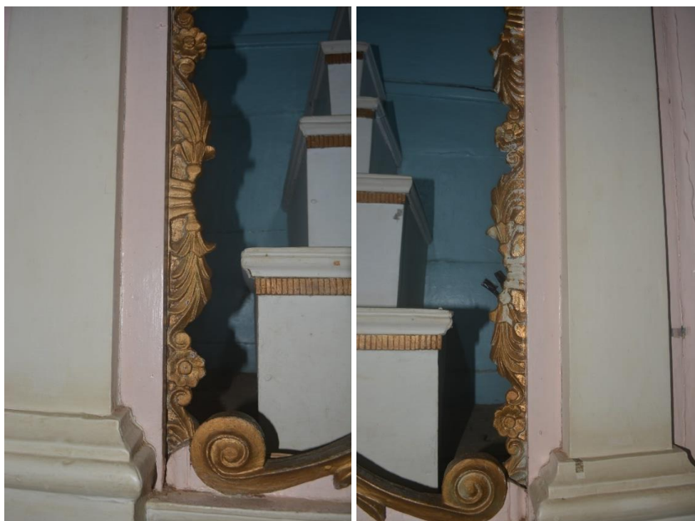
Figuras 30 e 31: Detalhe dos arremates das laterais do camarim
