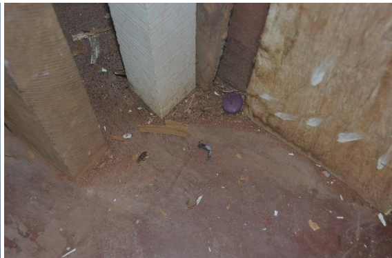
Foto 34: Estrutura do retábulo evidenciando galerias de insetos xilófagos
