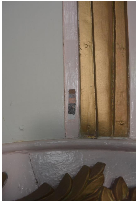
Foto 86: Prospecção frisos resplendor coroamento
