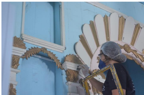
Foto 67: Teste de remoção de repintura
