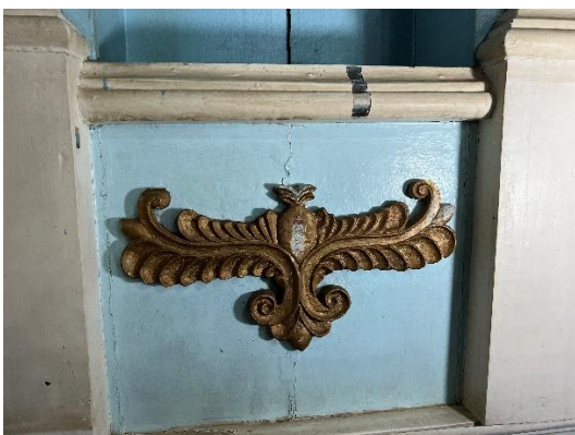
Foto 66: Detalhamento do corpo do retábulo
