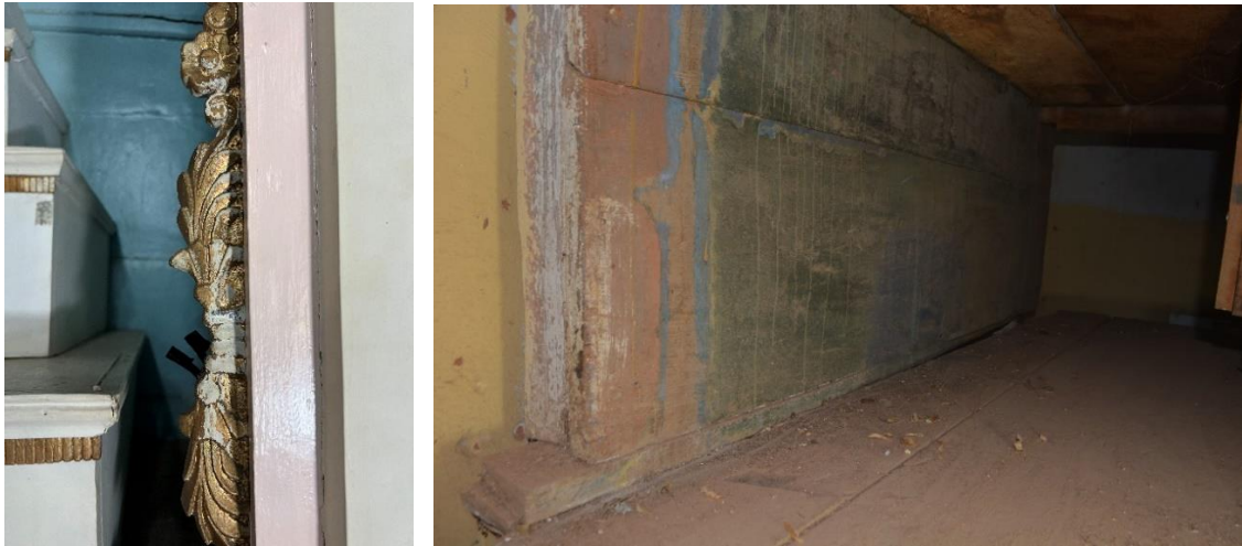
Figuras 64 e 65: Lambrequim do camarim com perda de douramento e tábuas atrás do sacrário na sequência do fechamento de fundo do camarim.
