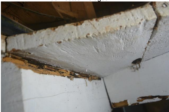
Foto 33: Estrutura do retábulo evidenciando galerias de insetos xilófagos
