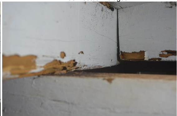
Foto 34: Estrutura do retábulo evidenciando galerias de insetos xilófagos
