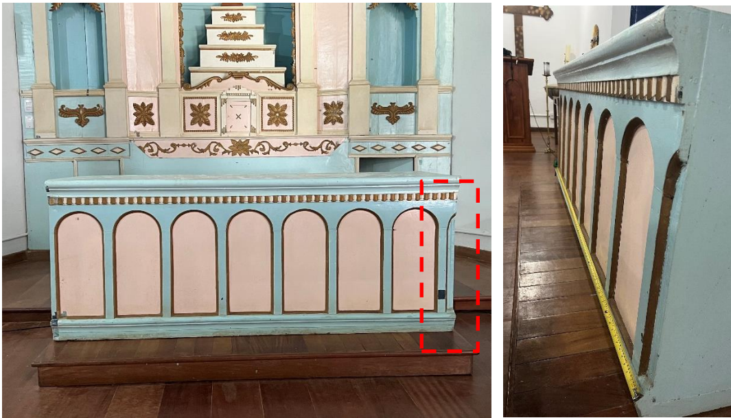
Figuras 36 e 37: Mesa do retábulo-mor, com detalhe do trecho amputado.
