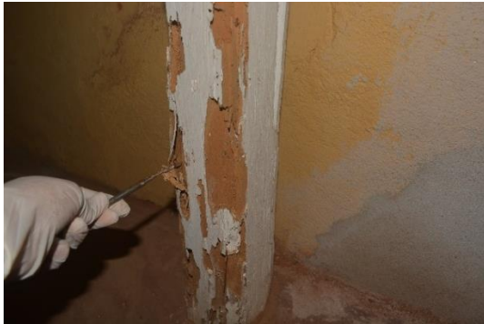
Foto 45: Abertura de galerias para análise do estado de conservação da estrutura do retábulo
