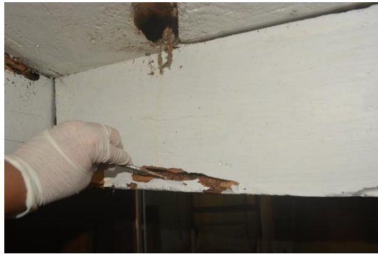
Foto 46: Abertura de galerias para análise do estado de conservação da estrutura do retábulo
