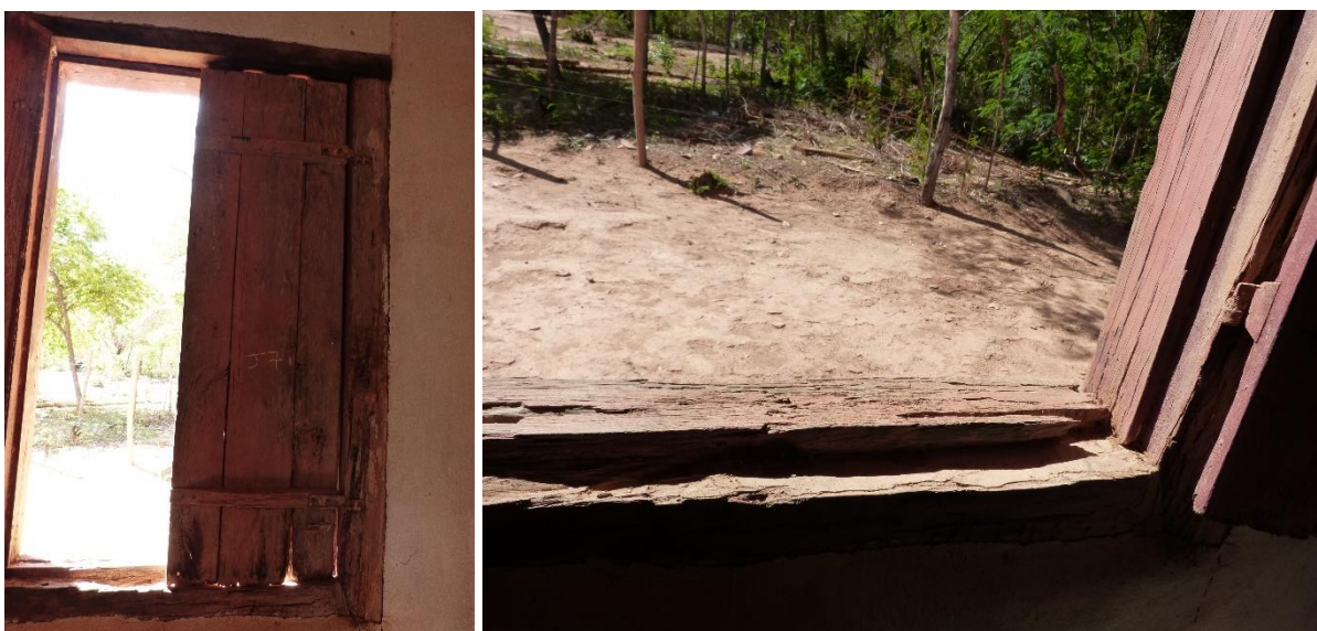
Fig. 98 – Detalhe do estado de conservação – Janela J7.
