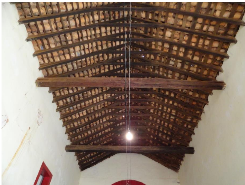
Fig. 04 – Estrutura em caibro armado e tirantes de madeira.
