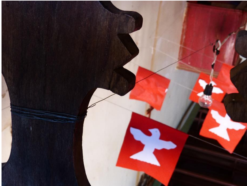
Fig. 109 – Detalhe do estado de conservação – Arames amarrados nas tábuas do guarda-corpo.
