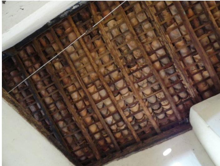
Fig. 06 – Estrutura do telhado – cômodos laterais.
