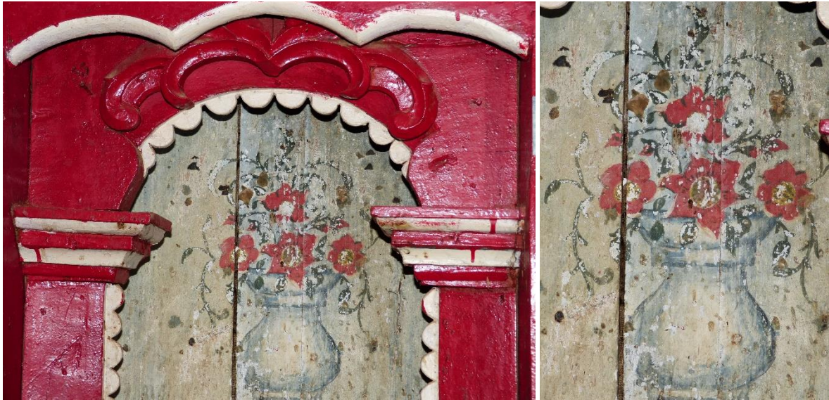
Fig. 164 – Detalhe do Nicho da Nave (lado direito) – Pintura parietal.
