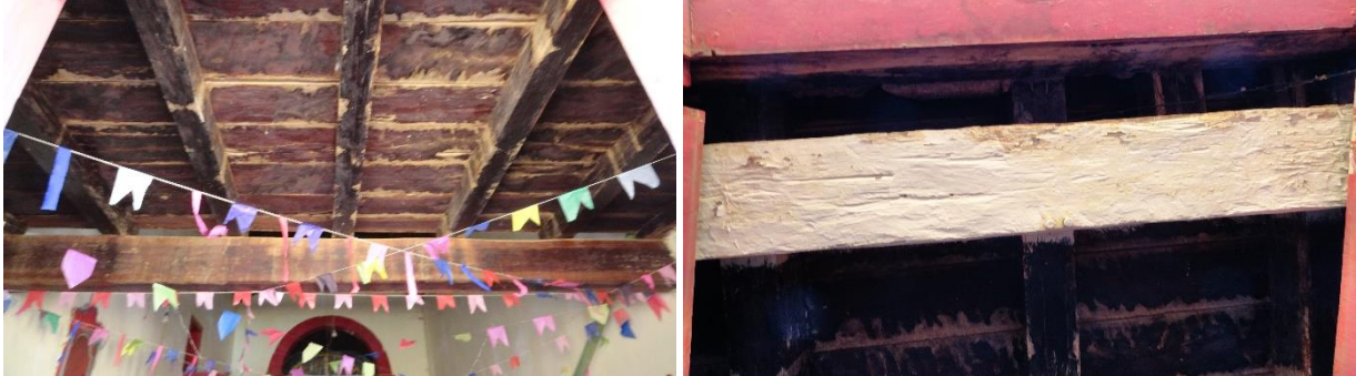
Fig. 106 – Detalhe do estado de conservação – Estrutura de sustentação do coro.
