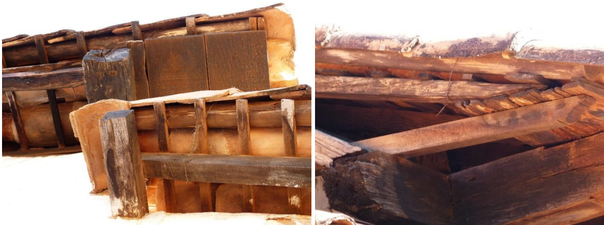
Fig. 44 – Amarração de peças da cobertura com arame.
