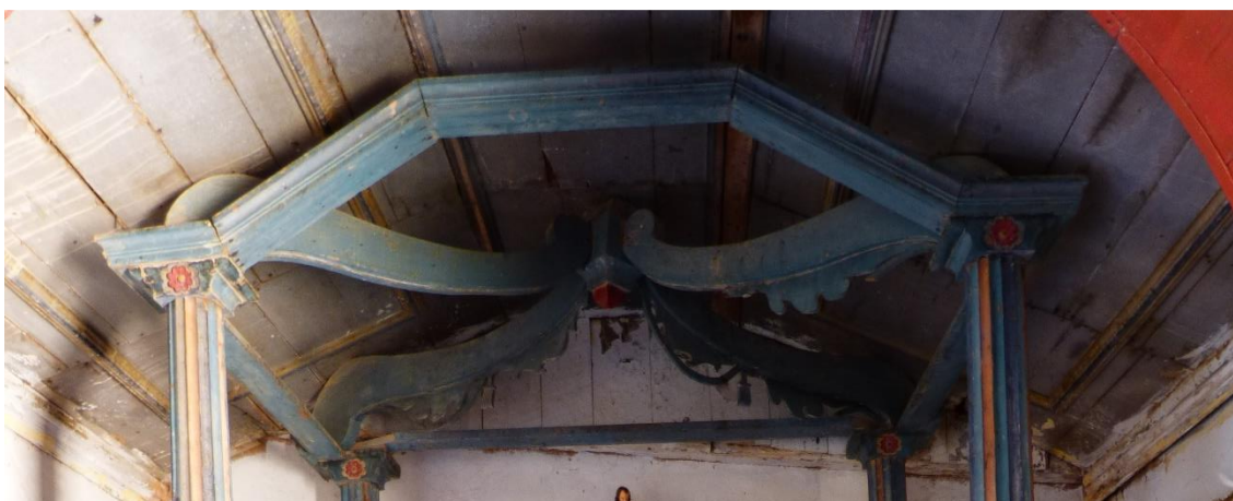
Fig. 140 – Detalhe do forro – Capela do Santíssimo Sacramento.
