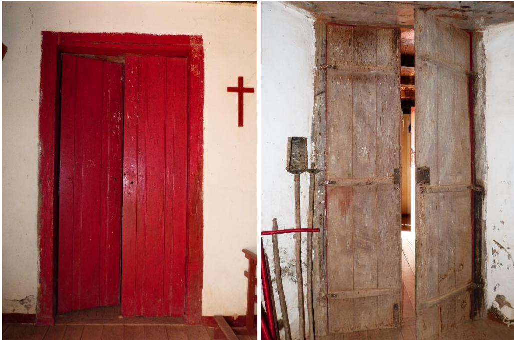
Fig. 90 – Detalhe das faces externa e interna da porta PA.
