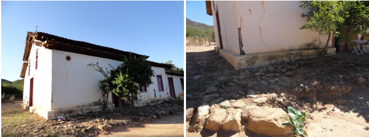
Fig. 80 – Detalhes do piso em pé de moleque no exterior da edificação.
