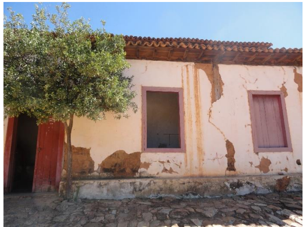
Fig. 33 – Comparação do avanço das rachaduras provocadas pela deterioração das bases dos esteios.
