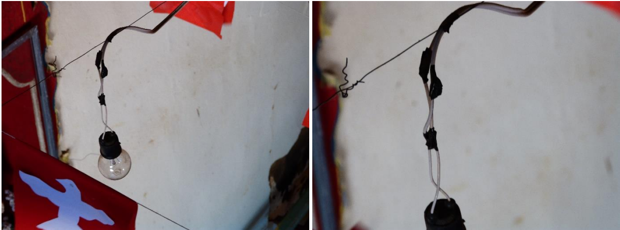
Fig. 130 – Detalhes da instalação elétrica executada na nave – isolamento das emendas nos fios.
