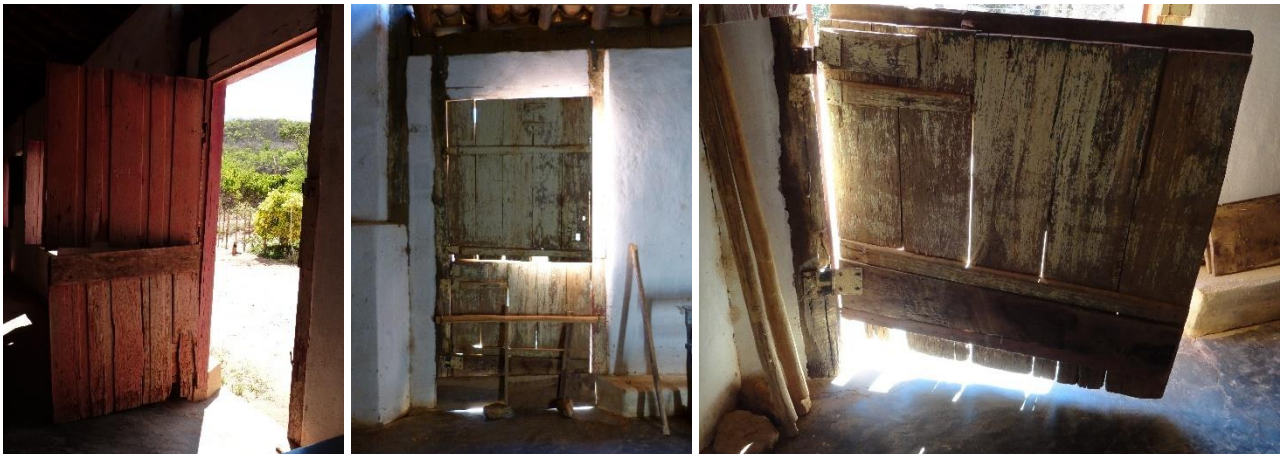
Fig. 91 – Detalhe das faces externa e interna da porta P4.
