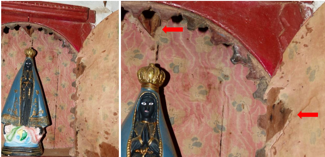
Fig. 162 – Detalhe do Nicho da Capela do Santíssimo (lado direito) – Acabamento em tecido nos fundos.
