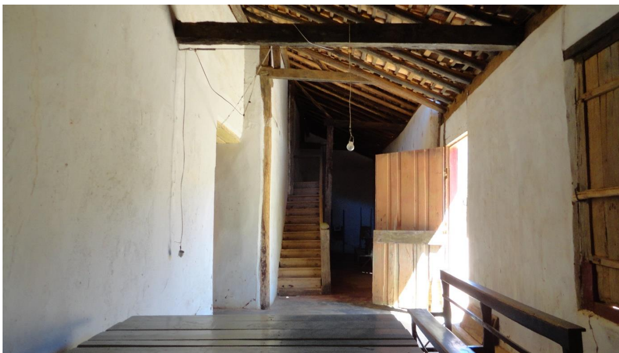
Fig. 134 – Detalhes da instalação elétrica – Fixação dos pontos de energia.
