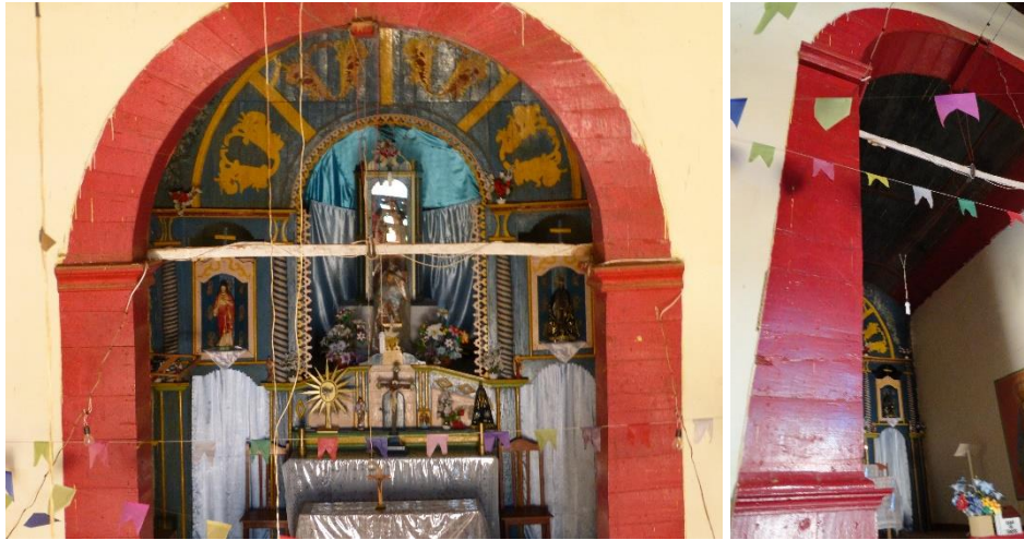
Fig. 121 – Detalhe do estado de conservação – Arco Cruzeiro.
