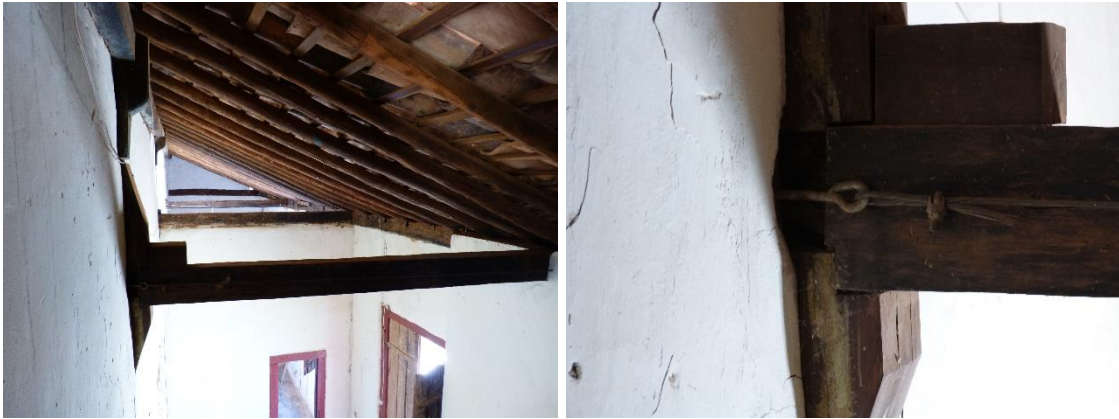
Fig. 43 – Atirantamento da estrutura de madeira com cabo de aço.
