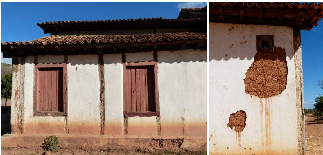
Fig. 65 – Peças de madeira da estrutura expostas após intervenções.
