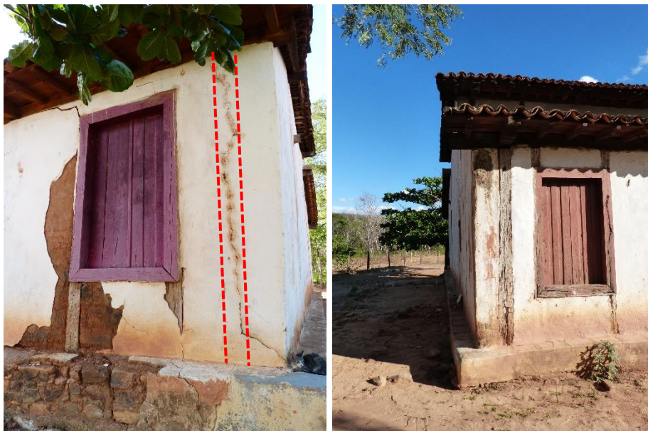
Fig. 40 – Posição dos cunhais na parte posterior da edificação.
