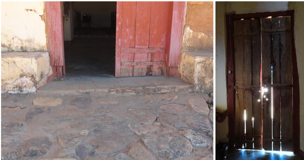
Fig. 95 – Detalhe das faces externa e interna da porta P2.
