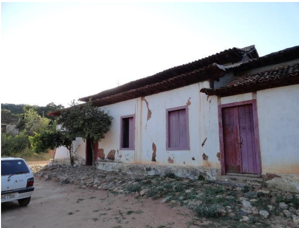
Fig. 33 – Comparação do avanço das rachaduras provocadas pela deterioração das bases dos esteios.
