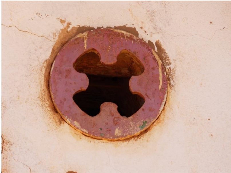
Fig. 118 – Detalhe do estado de conservação – Óculo da fachada lateral direita.
