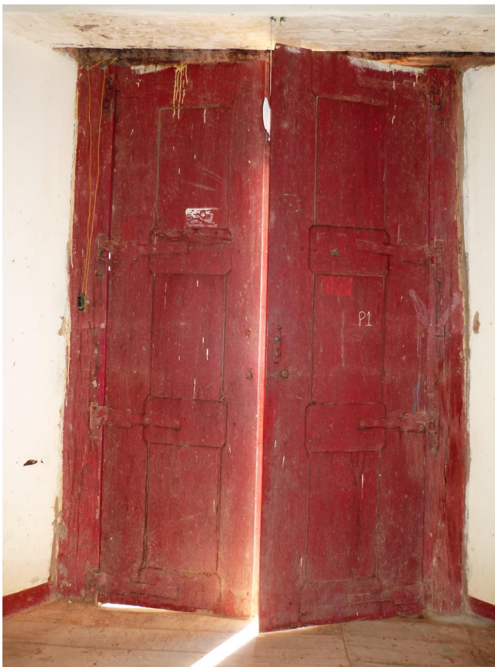
Fig. 89 – Detalhe da face interna da porta principal (P1).
