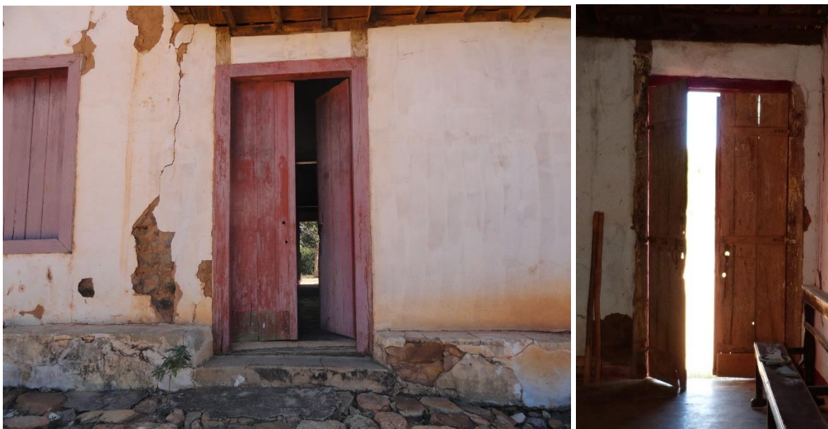
Fig. 93 – Detalhe das faces externa e interna da porta P3.
