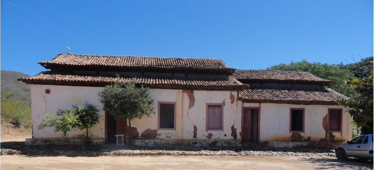
Fig. 26 – Estado de conservação da fachada lateral direita.
