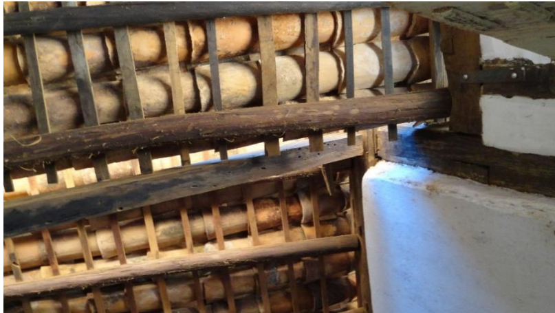
Fig. 15 – Detalhe da cobertura – Caibros em eucalipto roliço.
