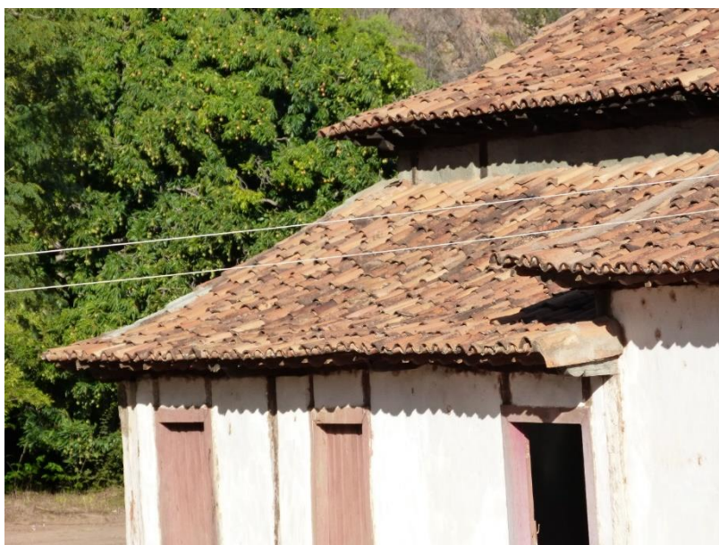
Fig. 05 – Telhado em uma água – cômodos laterais.
