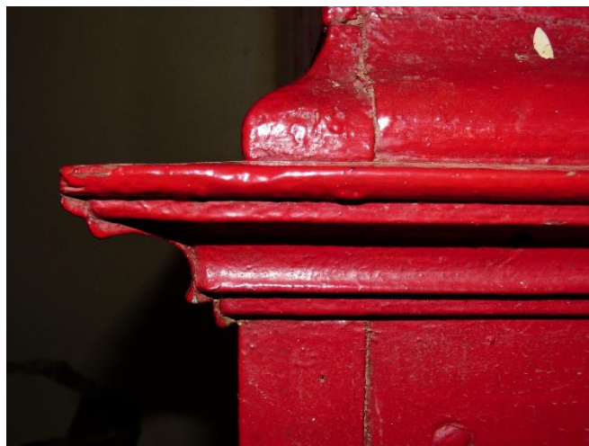
Fig. 123 – Detalhes das cornijas existentes no arco cruzeiro.
