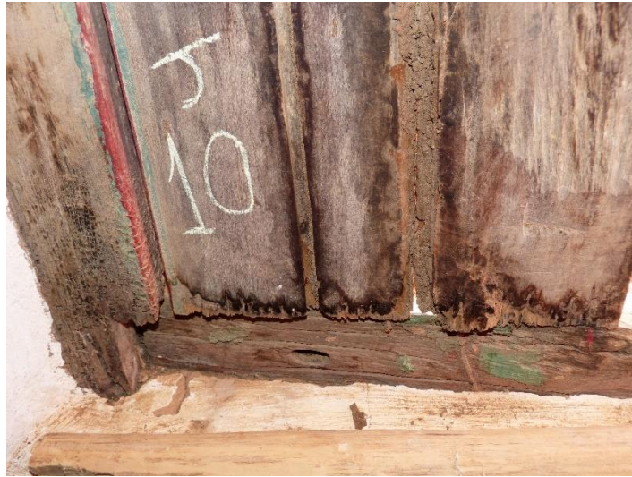
Fig. 99 – Detalhe do estado de conservação – Janela J10.
