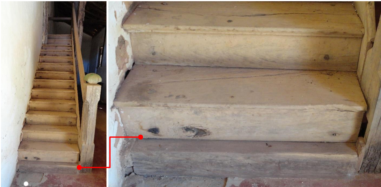
Fig. 85 – Detalhe do estado de conservação da escada – acesso ao púlpito.
