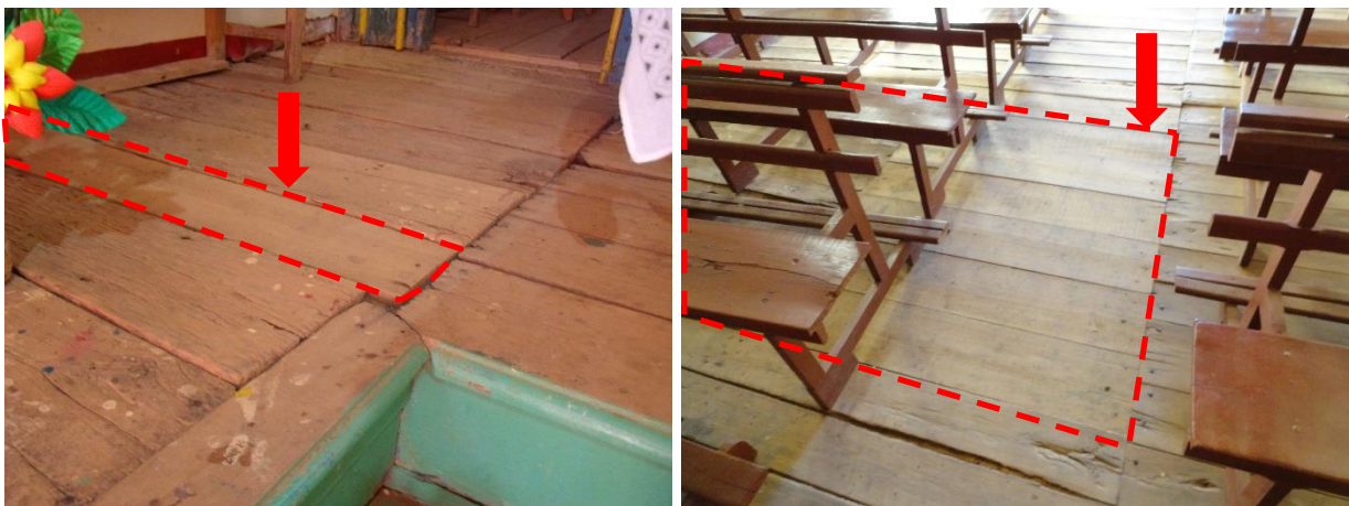
Fig. 69 – Substituição das tábuas originais por tábuas de pinus.
