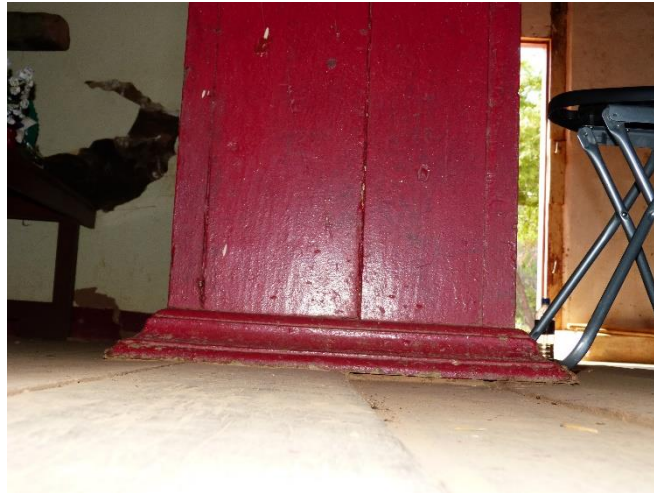
Fig. 124 – Detalhes do acabamento inferior do arco cruzeiro.
