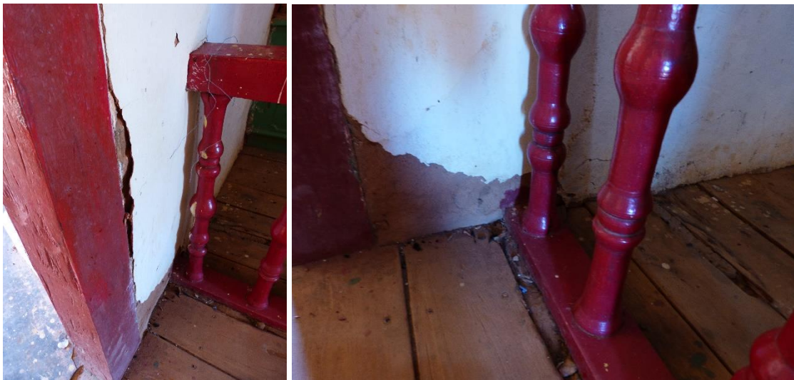
Fig. 174 – Detalhe do guarda-corpo da capela-mor – Estado geral de conservação.
