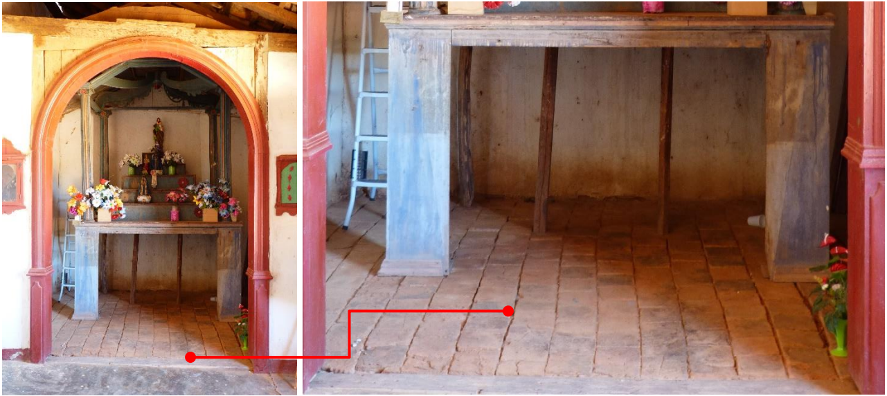
Fig. 73 – Detalhes do piso de lajotas cerâmicas da Capela do Santíssimo.
