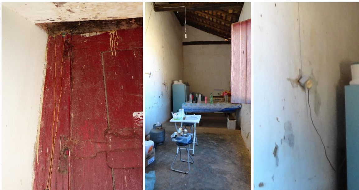
Fig. 133 – Detalhes da instalação elétrica – Fixação dos pontos de energia.
