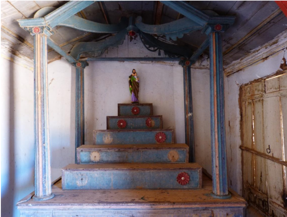
Fig. 139 – Detalhe do forro – Capela do Santíssimo Sacramento.
