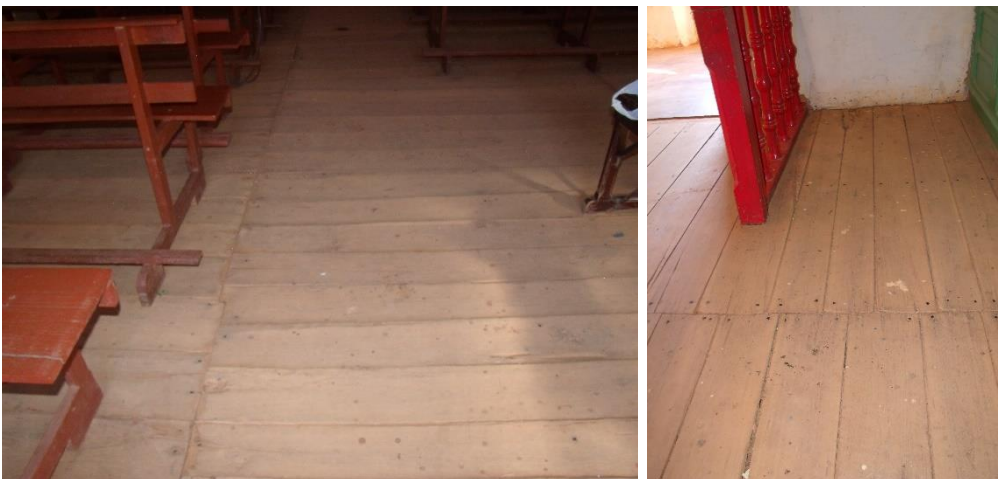
Fig. 66 – Detalhe do assoalho – Nave / Capela-Mor.
