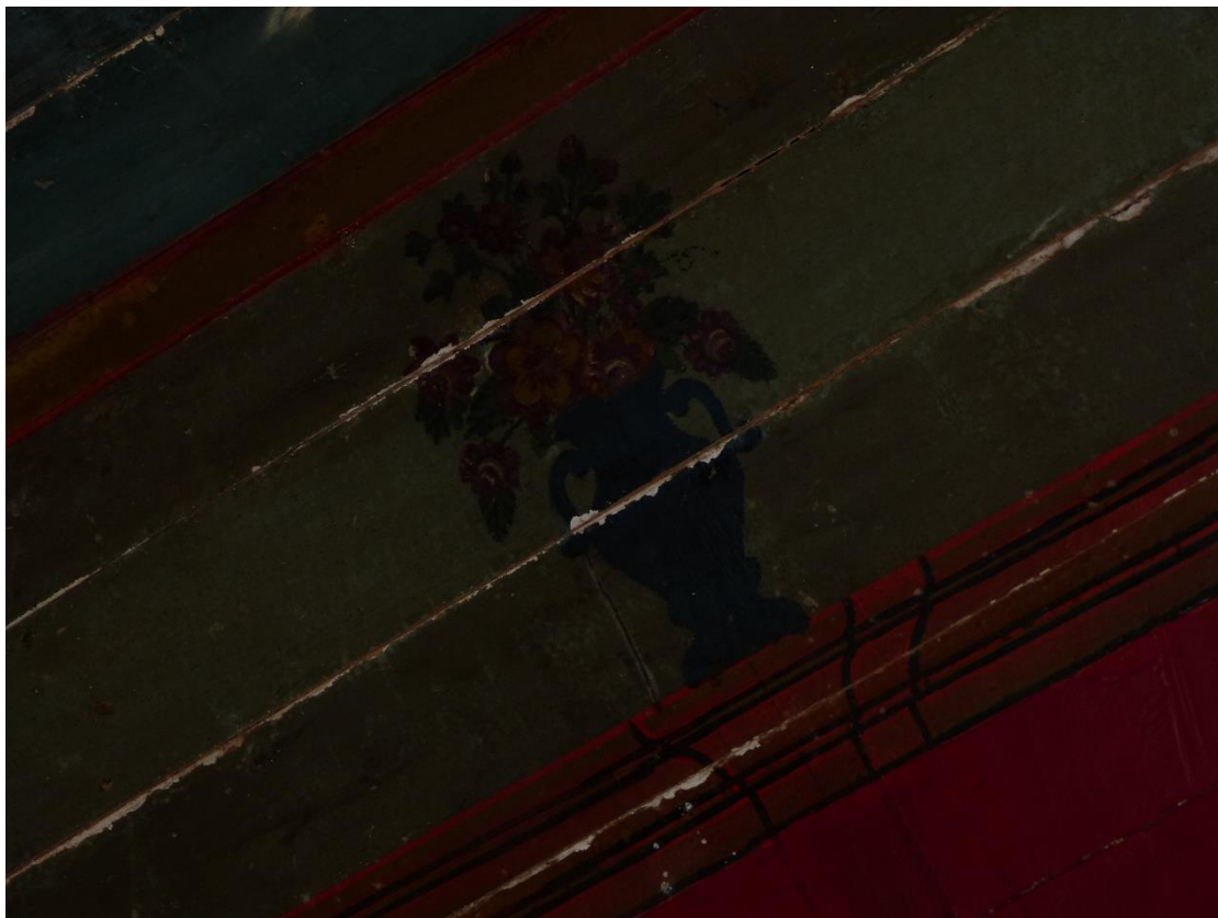
Fig. 137 – Detalhe do forro da capela-mor – Pinturas parietais.
