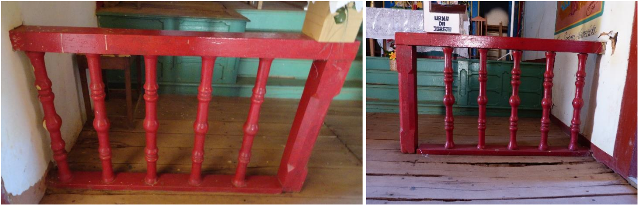
Fig. 173 – Detalhe do guarda-corpo da capela-mor – Estado geral de conservação.
