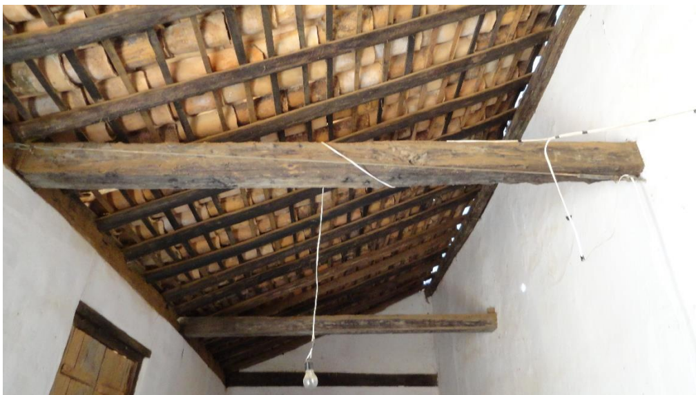
Fig. 132 – Detalhes da instalação elétrica executada na sacristia lateral esquerda.
