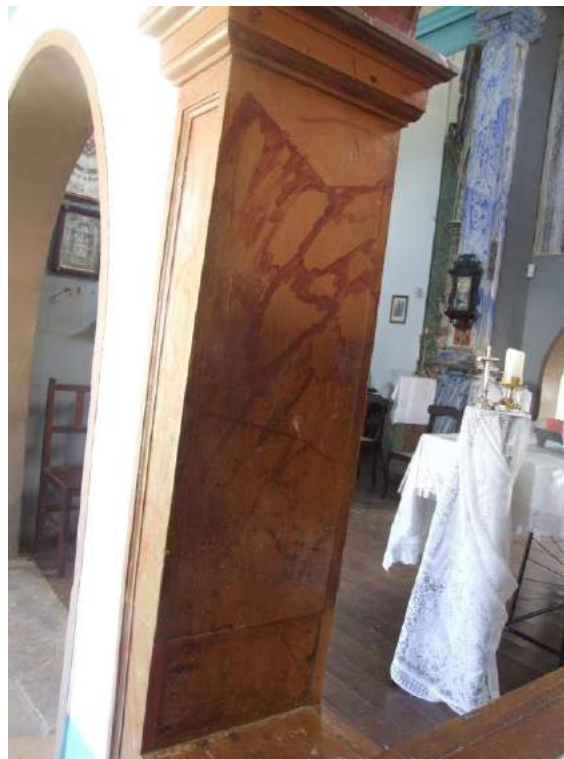
Foto 28 – Pinturas parietais e cimalha – Pintura mais nova imitando mármore no arco.
