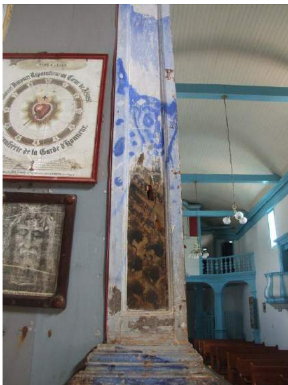
Fotos 40 e 41 – Arco cruzeiro – Prospecções exibindo pintura mais antiga sobre marmorizado mais recente.
