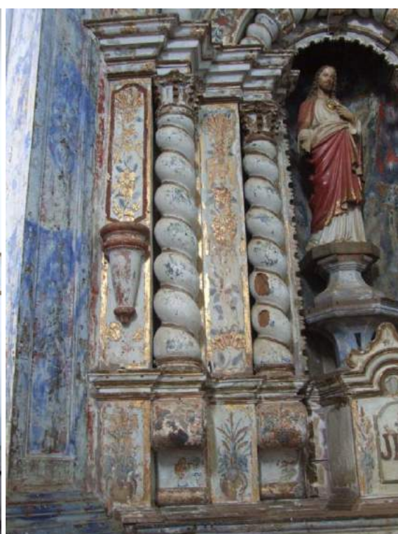
Fotos 55 e 56 – Retábulo arco cruzeiro lado da epístola – Galerias de insetos xilófagos, repintura com perdas exibindo pintura antiga.
