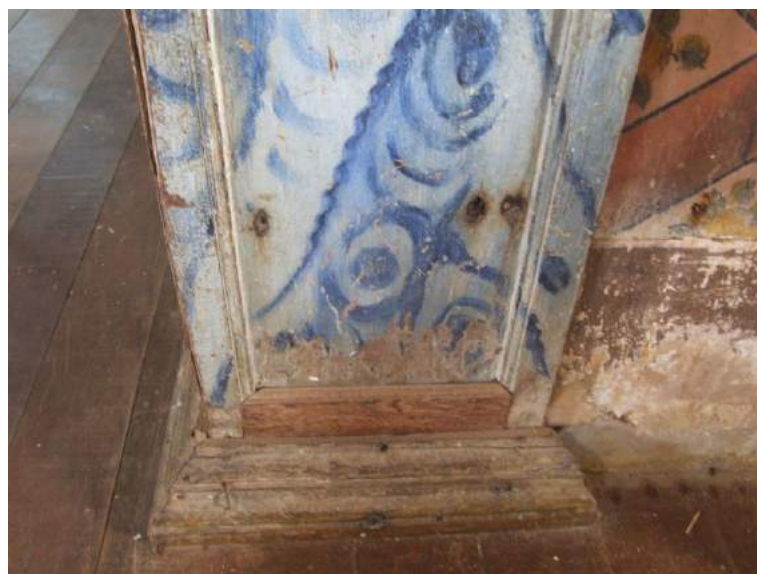
Foto 47 – Arco cruzeiro – Substituição de friso/arremate de madeira.
