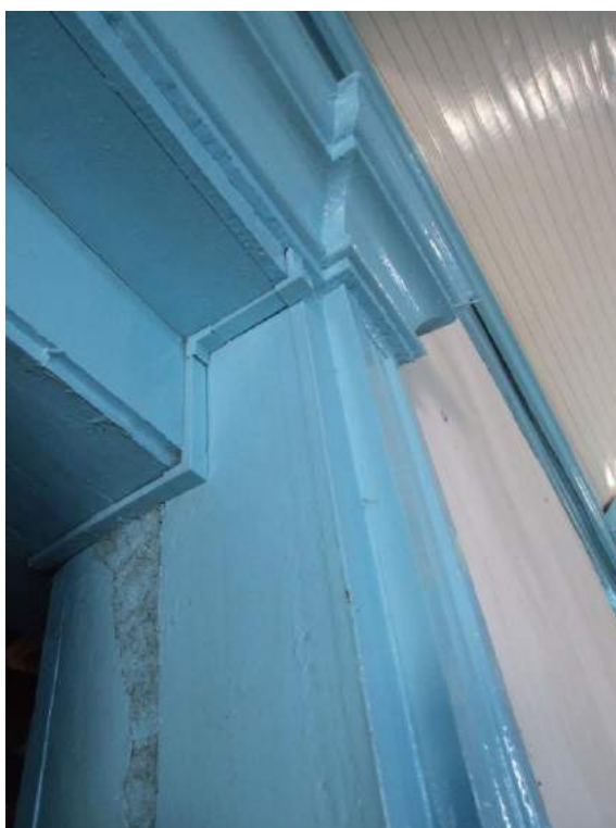
Foto 62 – Púlpito – Substituição de suporte por tábuas de serra elétrica.
