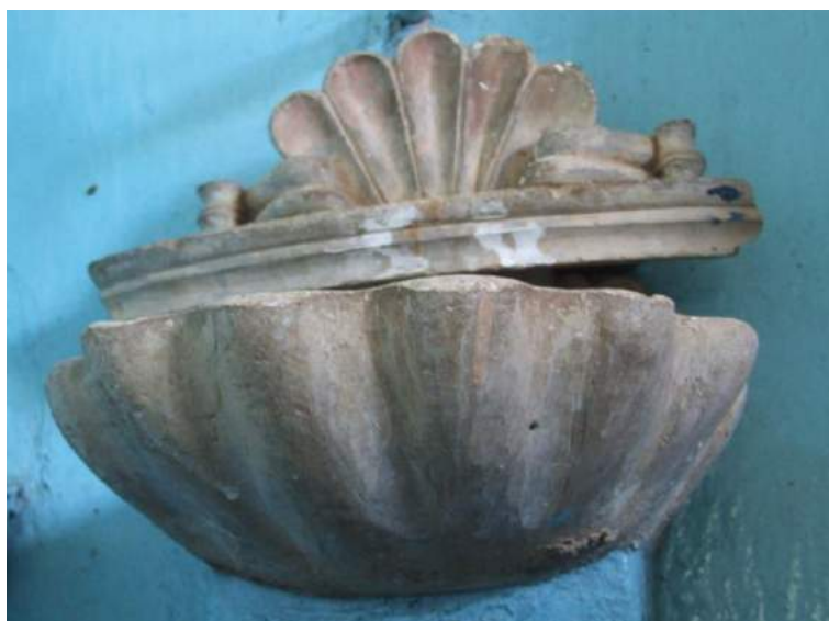
Foto 88 – Lavabo da Sacristia – Remontagem de parte do lavabo e manchas.
