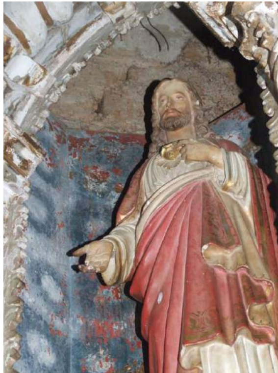
Foto 57 – Retábulo arco cruzeiro lado da epístola – Detalhes do camarim exibindo perda do forro.
