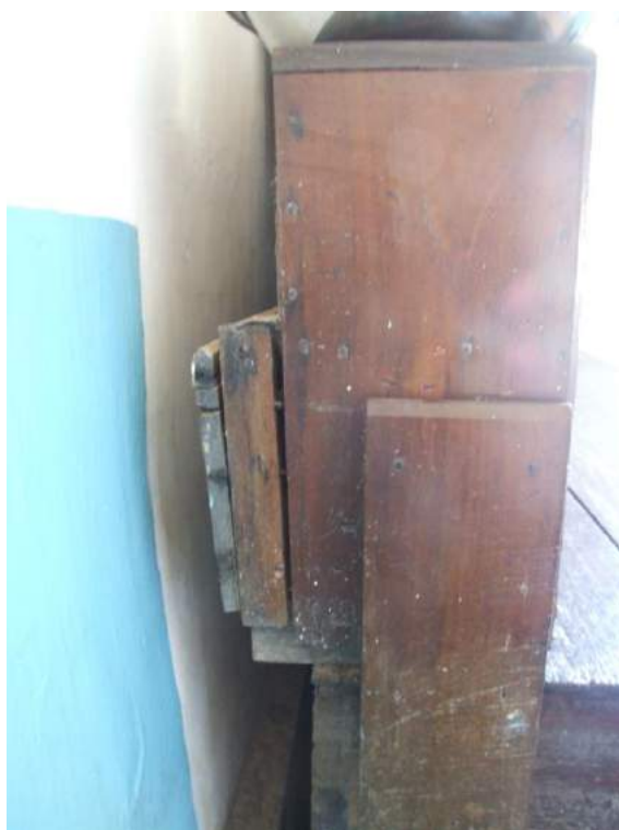
Foto 84 – Retábulo da Sacristia – Tábuas unindo partes dos móveis.
