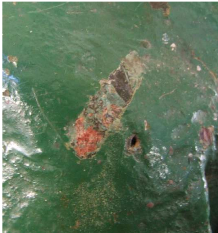
Foto 120 – São Sebastião – Prospecção feita na base.
