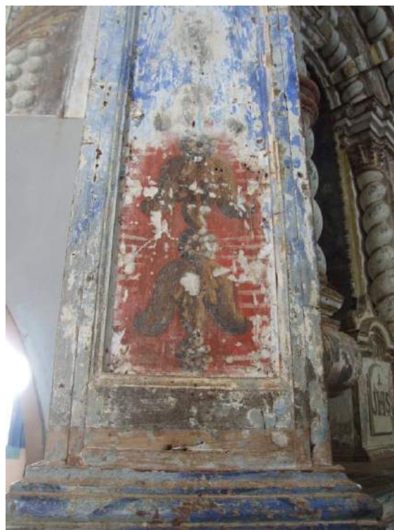
Fotos 40 e 41 – Arco cruzeiro – Prospecções exibindo pintura mais antiga sobre marmorizado mais recente.
