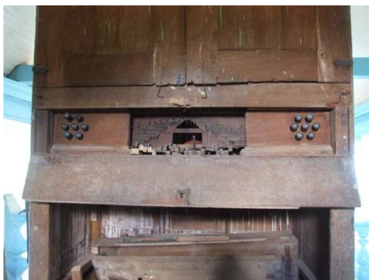
Foto 74 – Órgão – Fechaduras e dobradiças oxidadas e substituídas.
