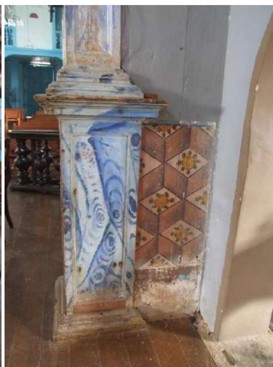
Fotos 42 e 43 – Arco cruzeiro – Perda de pintura, fio elétrico, repintura e referência única de pintura na parede lateral do arco.
