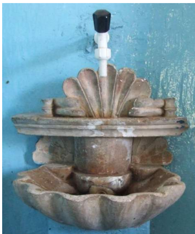
Foto 87 – Lavabo da Sacristia – Perda de suporte e manchas.
