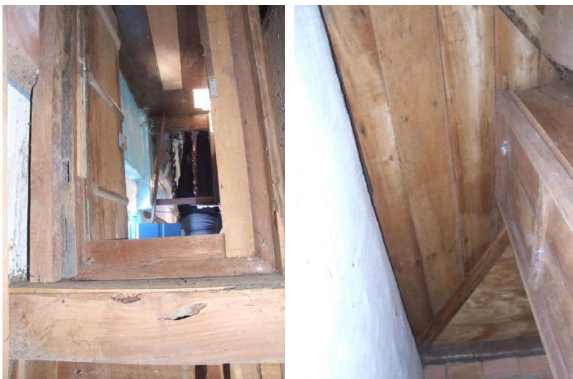
Fotos 81 e 82 – Retábulo de Nossa Senhora das Dores – Visão detrás com tabuado novo.
