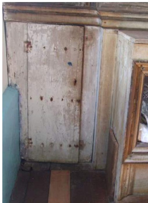
Foto 80 – Retábulo de Nossa Senhora das Dores – Substituição de madeira no sarcófago.
