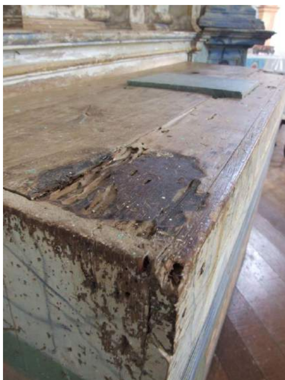
Fotos 53 e 54 – Retábulo arco cruzeiro lado do evangelho – Insetos xilófagos, abrasões, queimas, perdas da repintura deixando visível pintura antiga.
