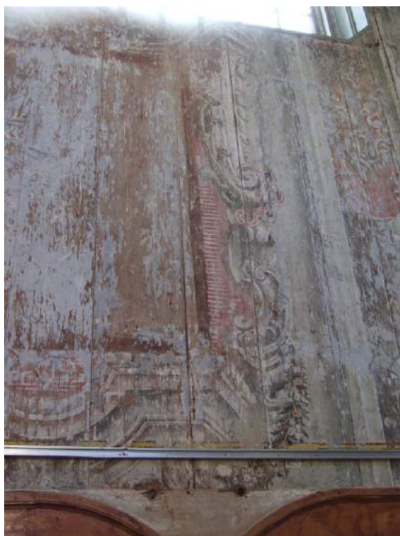
Foto 26 – Pinturas parietais e cimalha – Detalhes da pintura subjacente.
