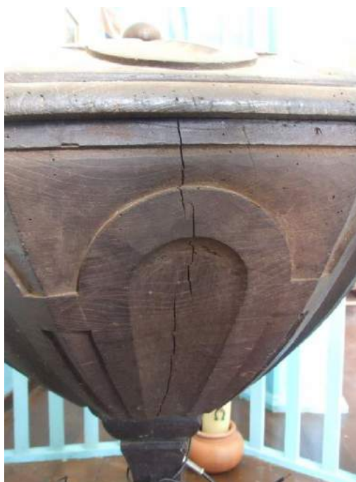
Foto 69 – Pia Batismal – Rachadura na bacia
