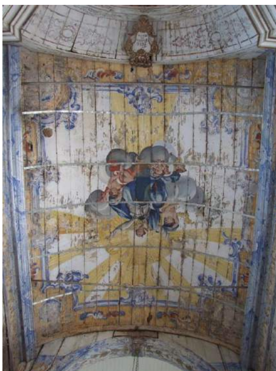
Foto 31 – Forro da capela-mor – Vista geral.
