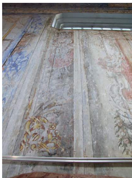
Fotos 22 e 23 – Pinturas parietais e cimbalha – Resquícios da repintura e pintura original com perdas, manchas e abrasões.
