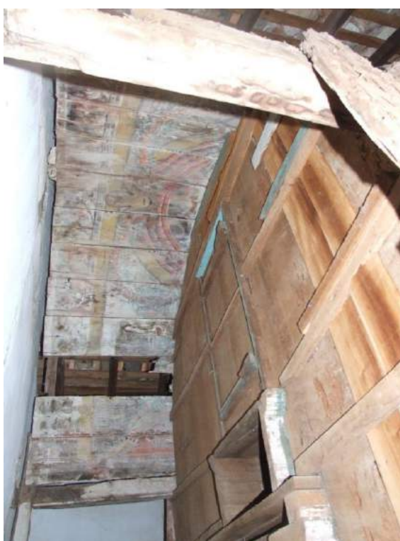
Foto 11 – Retábulo-mor – Atrás do camarim com forro trespassando
