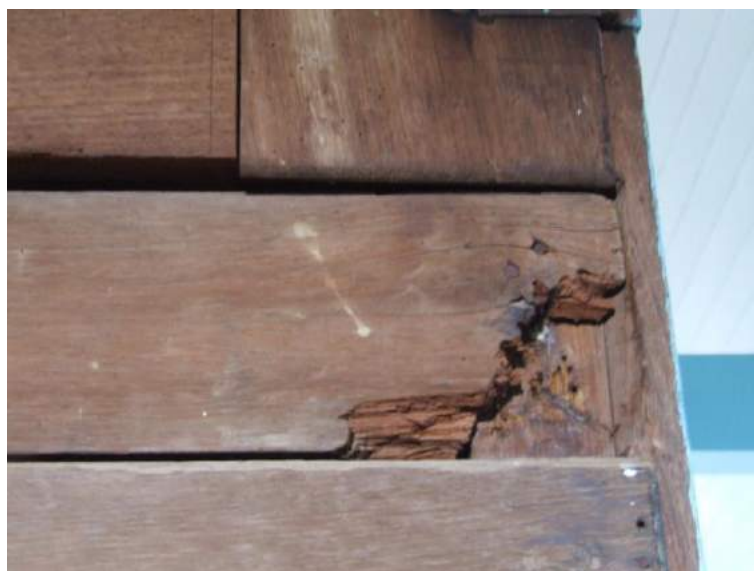
Foto 73 – Órgão – Ataques de cupins e furos de pregos.
