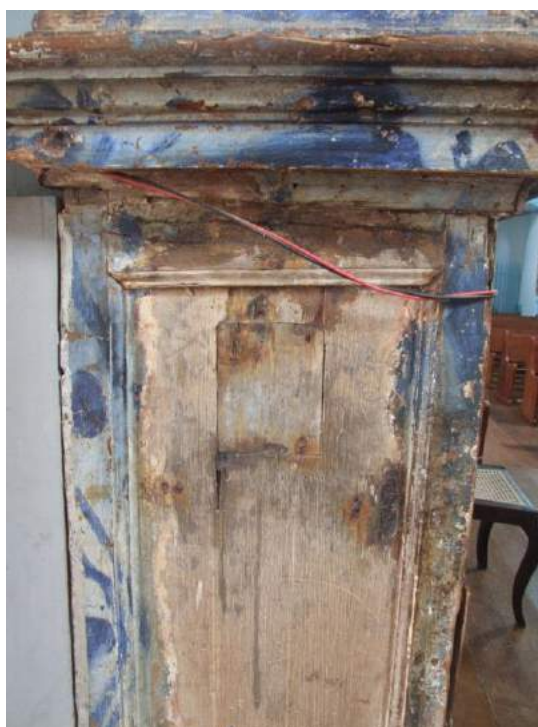
Fotos 42 e 43 – Arco cruzeiro – Perda de pintura, fio elétrico, repintura e referência única de pintura na parede lateral do arco.
