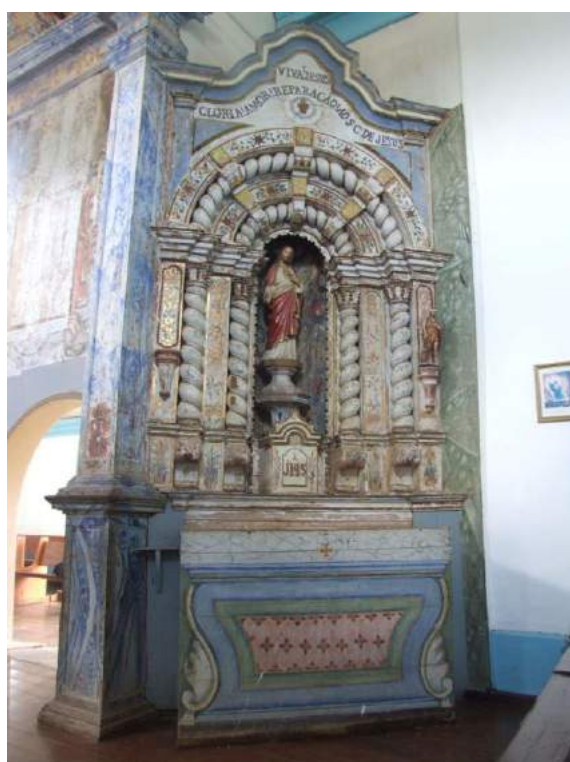
Fotos 55 e 56 – Retábulo arco cruzeiro lado da epístola – Galerias de insetos xilófagos, repintura com perdas exibindo pintura antiga.
