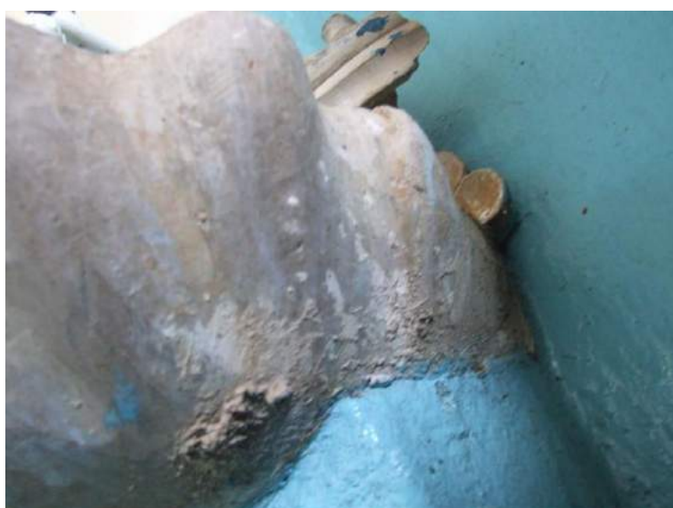
Foto 91 – Lavabo da Sacristia – Cimento e tinta aderidos no suporte.
