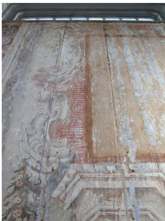
Fotos 22 e 23 – Pinturas parietais e cimbalha – Resquícios da repintura e pintura original com perdas, manchas e abrasões.
