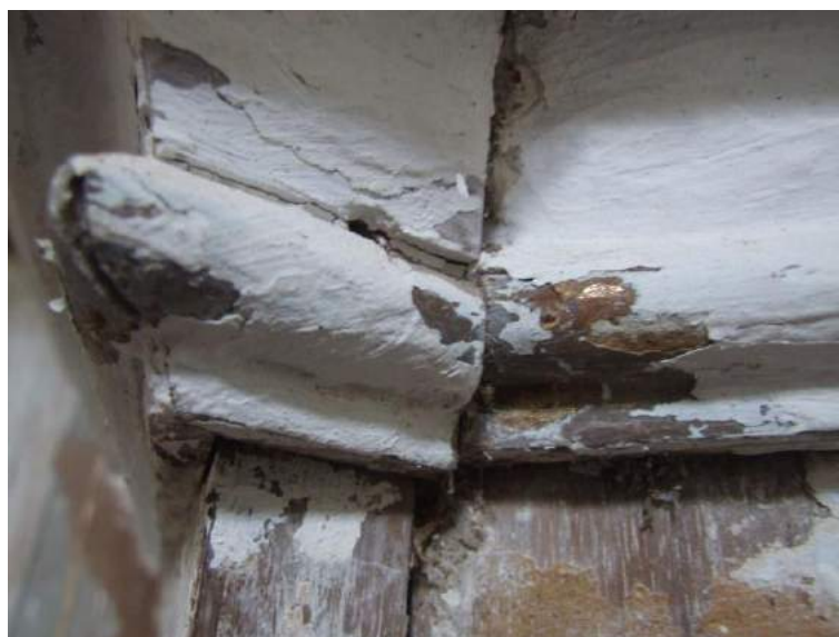
Foto 8 – Retábulo-mor – Abertura nas junções e repintura sobre ouro brunido.
