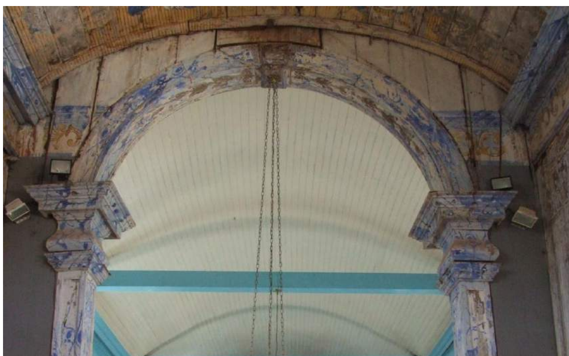
Foto 39 – Arco Cruzeiro – Arco e entablamentos com repintura.
