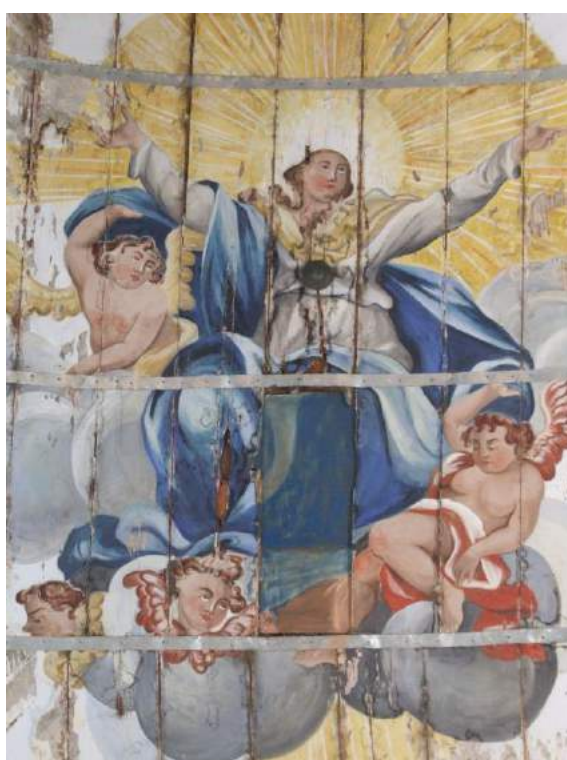
Fotos 32 e 33 – Forro da capela-mor – Pintura central com arandela de lustre, perdas e substituição de suporte.
