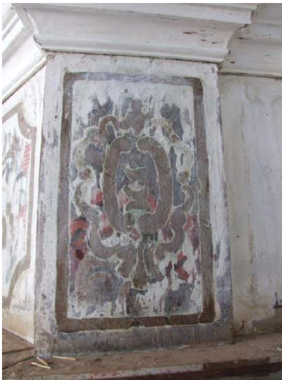
Foto 2 e Foto 3 – Retábulo-mor – Repintura branca, purpurina oxidada e perdas generalizadas de pinturas.
