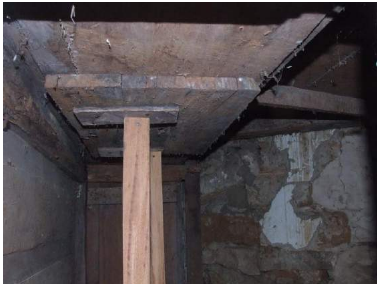
Foto 59 – Retábulo arco cruzeiro lado da epístola – Alterações e degradações no interior da mesa.
