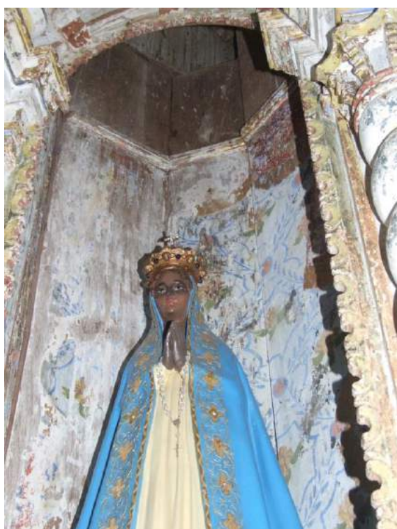
Fotos 51 e 52 – Retábulo arco cruzeiro lado do evangelho – Perda forro do camarim e perdas de pintura.
