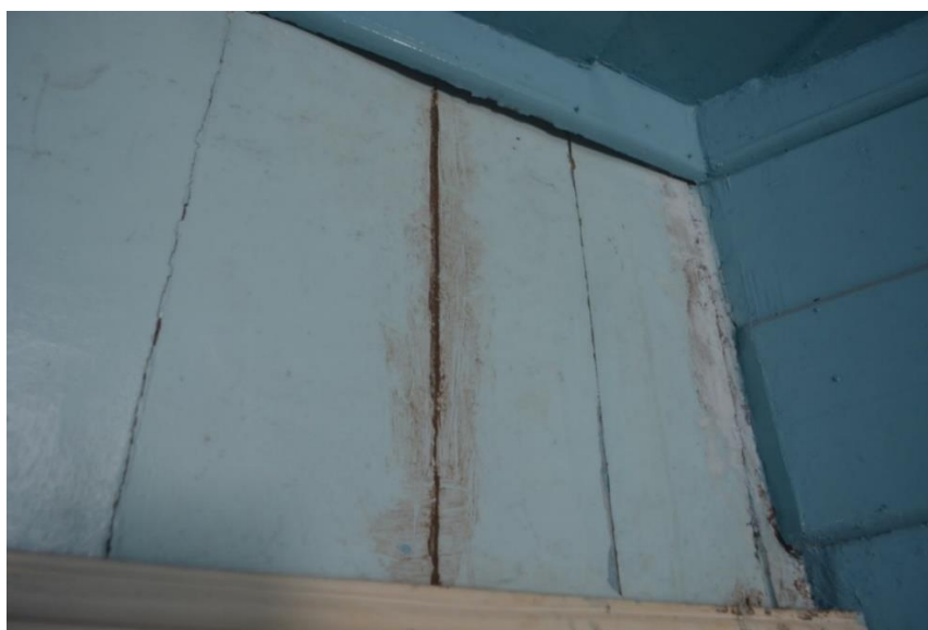
Figura 45: Umidade no canto superior direito do retábulo e Deslocamento de tábuas.
