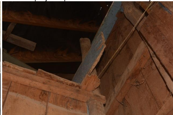
Foto 38: Estrutura do retábulo evidenciando cabeamento elétrico e pichação
