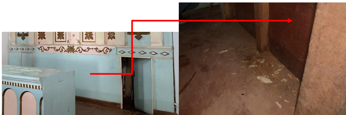
Figuras 50 e 51: Fechamento do vão da mesa do retábulo em chapa de compensado naval.
