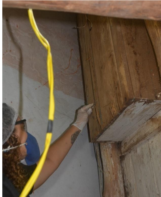
Foto 52: Abertura de galerias para análise do estado de conservação da estrutura do retábulo
