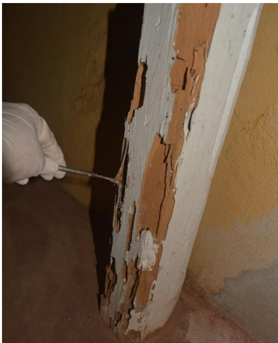
Foto 51: Abertura de galerias para análise do estado de conservação da estrutura do retábulo
