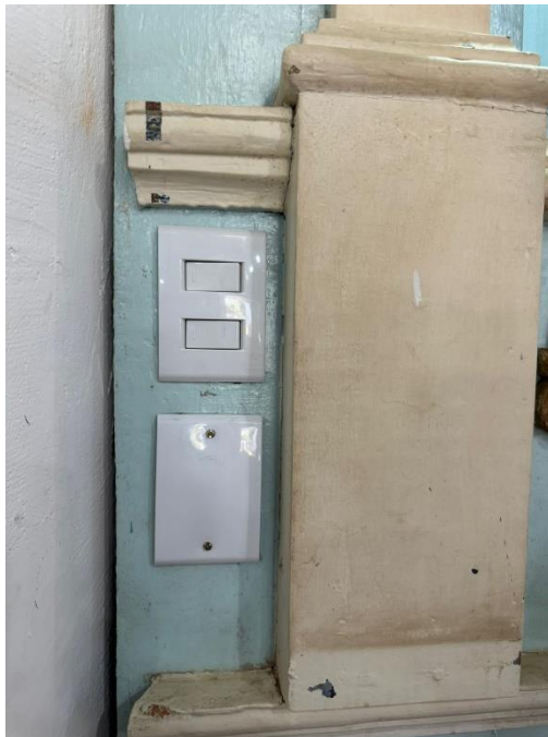
Figura 81 - Intervenção: instalação de tomadas
