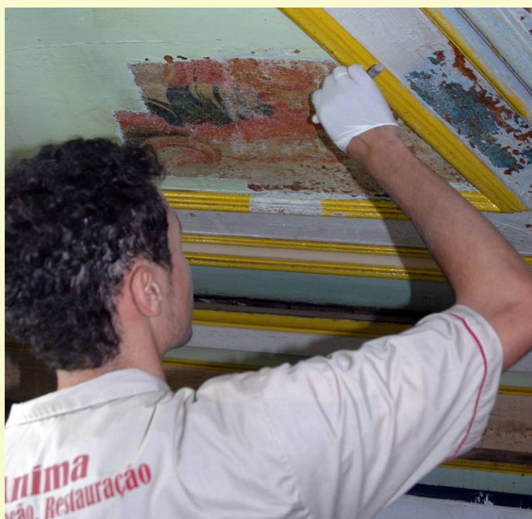
Remoção de cinco camadas de pintura revelou a surpresa
