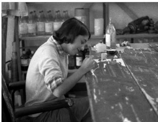
Carla Castro Silva restaurando o forro da Igreja de Nossa Senhora do Pilar. Autoria de Ivan Carvalho Melo, 1985. Sabará/MG.
