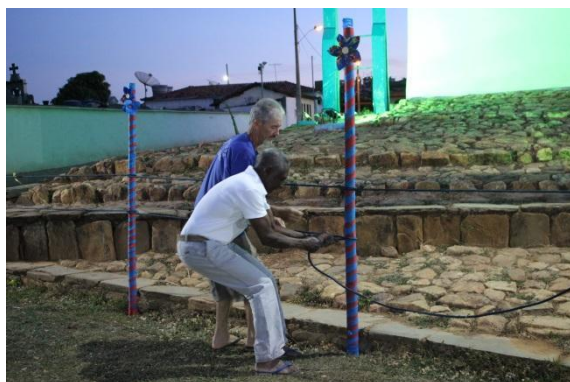
Figura 71: Homens trabalhando no cercamento da arena
