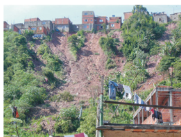
Figura 3.8 – Acidente de escorregamentos planares induzidos pela ocupação.
