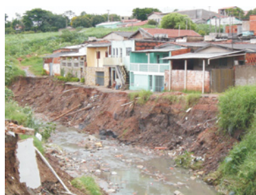
Figura 5.8 – Situação de risco associada a erosão e solapamento dos taludes marginais, com ocupação ribeirinha.
