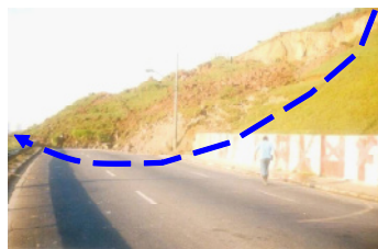
Figura 3.10 – Escorregamento circular ou rotacional.
