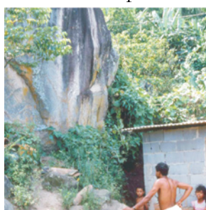
Figura 3.16 – Situação de risco de tombamento de bloco rochoso.
