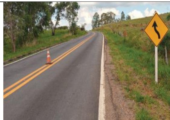
Recuperação Funcional da Rodovia AMG-420, trecho BR-040 (Ressaquinha) – Senhora dos Remédios
