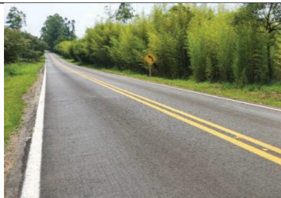
Recuperação Funcional da Rodovia MG-338, trecho Ibertioga – Campolide
