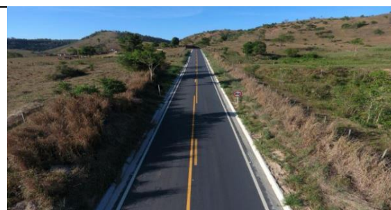
MG-105 - Recuperação Funcional dos Pavimentos nos trechos Águas Formosas – Pavão
