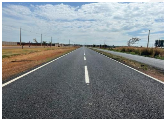
Recuperação Funcional da Rodovia AMG-2595, trecho Uberaba – Distrito Industrial III
