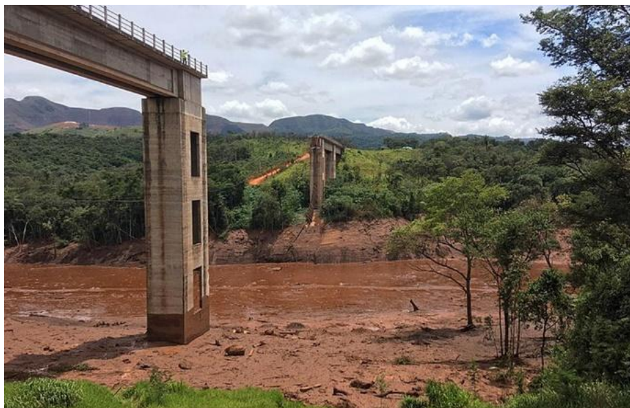
Imagem 25 - Rompimento da barragem em Brumadinho, 2019.
