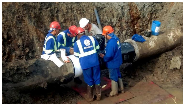
Imagem 11 - Vazamento de gasolina em duto sendo contido, em Araporã, em 2017.
