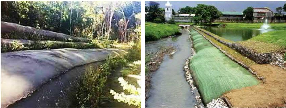
Figura 6.20. Proteção de margens com o uso de geotubos.
