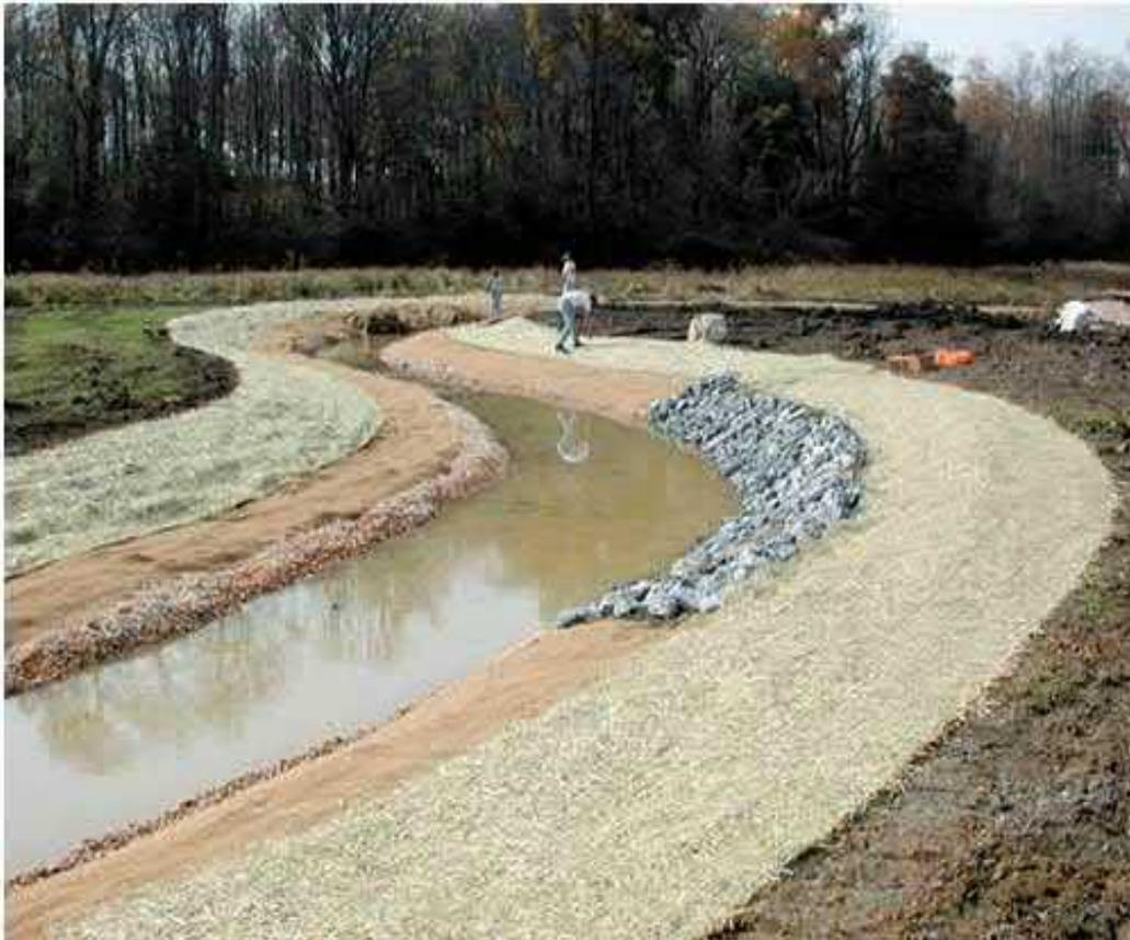
**Figura 6.3. Exemplo prático de uma aplicação de manta geotêxtil para proteção das feições convexas das margens fluviais.**
