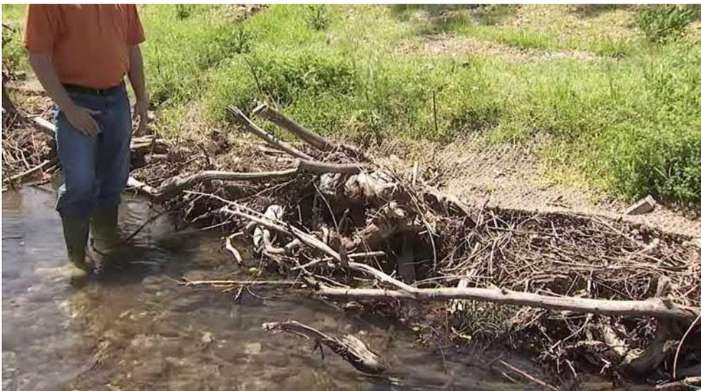
**Figura 6.7. Ilustração de estrutura natural, tipo Toe Wood, que auxilia no disciplinamento do escoamento superficial no eixo do leito propriamente dito e na contenção da erosão de margens, além de proporcionar habitat, com proteção e cobertura para as espécies aquáticas.**
