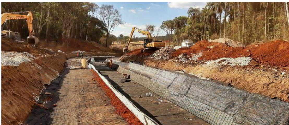
**Figura 5.17. Vista geral da construção da seção do canal e preenchimento das laterais com aterro compactado**
