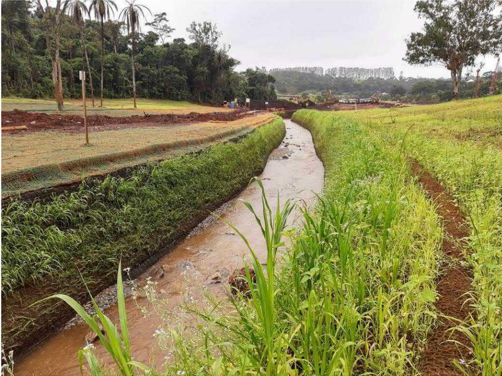
**Figura 5.23. Detalhe da seção construída onde é possível notar o escoamento no leito e início do desenvolvimento da vegetação nas margens do canal.**
