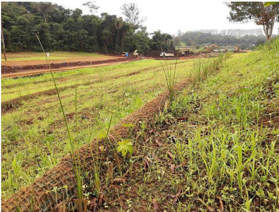
**Figura 5.27. Técnicas de conservação de solo adotadas no Marco Zero.**
