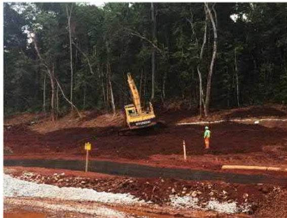
Figura 5.18. Aplicação de *topsoil*.
