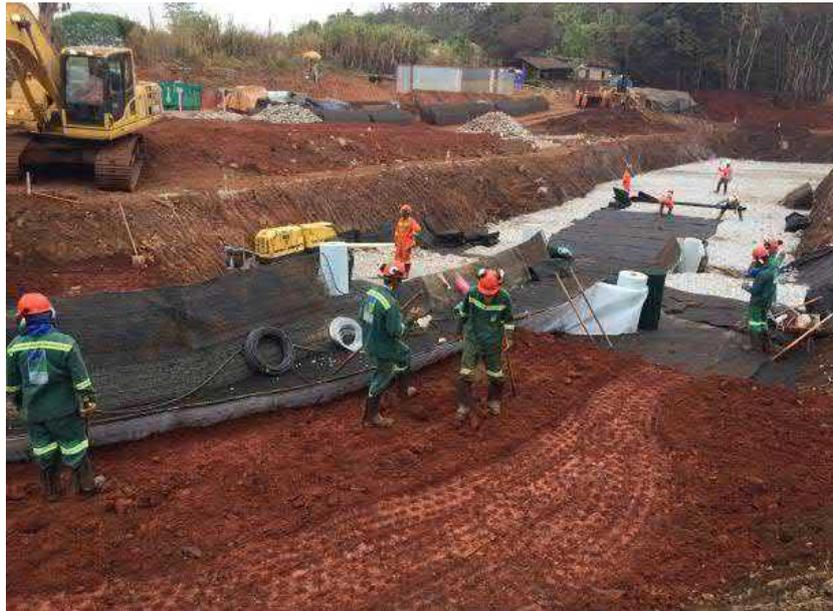
**Figura 5.16. Detalhe da margem do canal com aterro compactado.**
