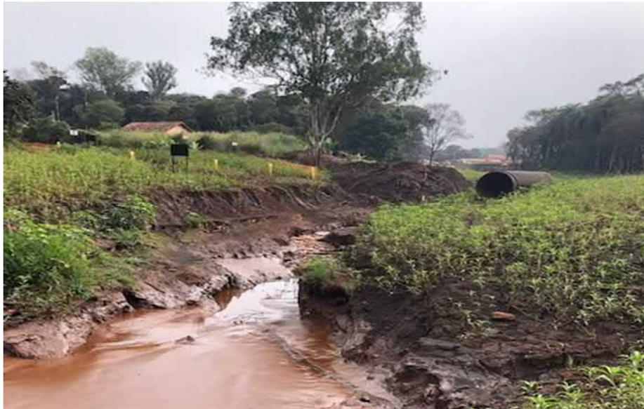
**Figura 5.3. Processos erosivos formados na região da faixa de dutos da Transpetro.**
