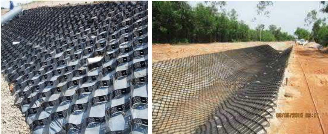
Figura 6.22. Proteção de margens com o uso de geocélulas.
