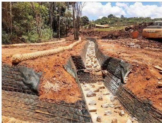
**Figura 5.26. Detalhe do revestimento do leito das drenagens à montante do canal.**
