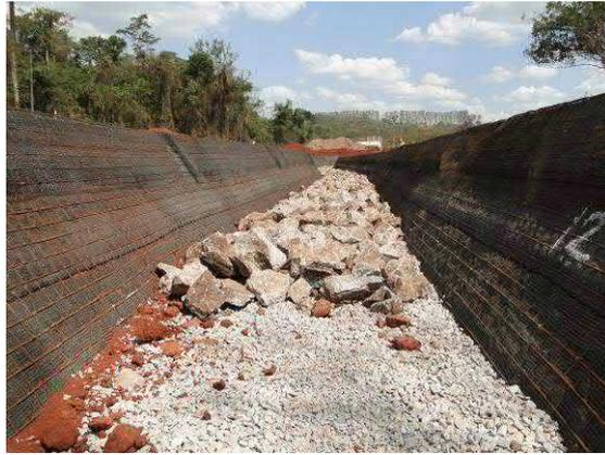
**Figura 5.25. Detalhe do revestimento do leito do canal.**
