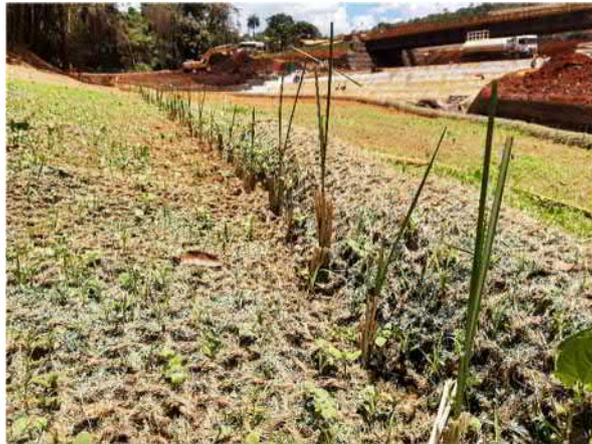
**Figura 5.20. Aplicação de retentor de sedimentos, revestimento com biomanta e plantio de capim Vetiver.**
