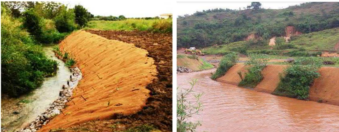
**Figura 6.19. Proteção de margens com o uso de biomantas antierosivas.**
